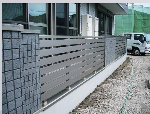
アルミ製 15×100 横格子タイプ ベランダ手摺
