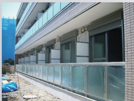
ポリカーボネート製面材 ベランダ手摺
