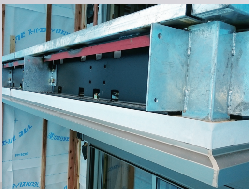
アルミ製立ち上り付下端笠木
