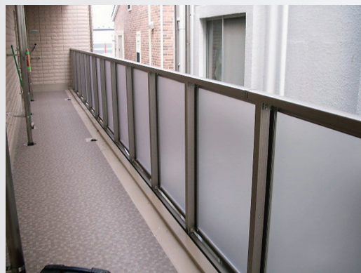
ポリカーボネート製面材 通路手摺
