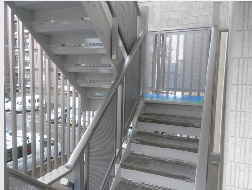
アルミ複合板パンチング 階段手摺
